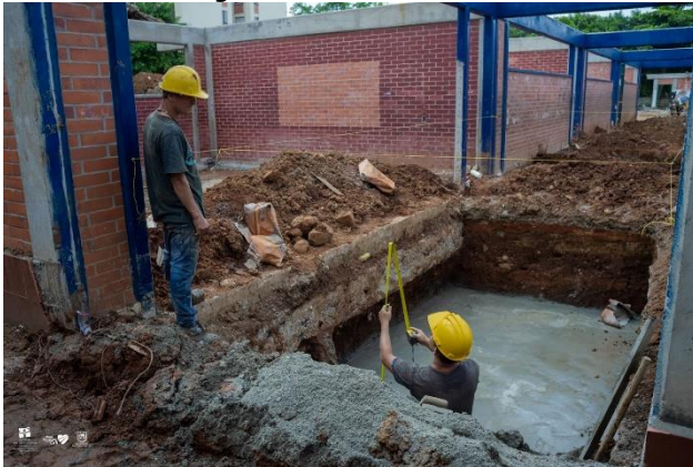
Fig. 7 Fotografía recorrido avances obra El Lido. Junio
